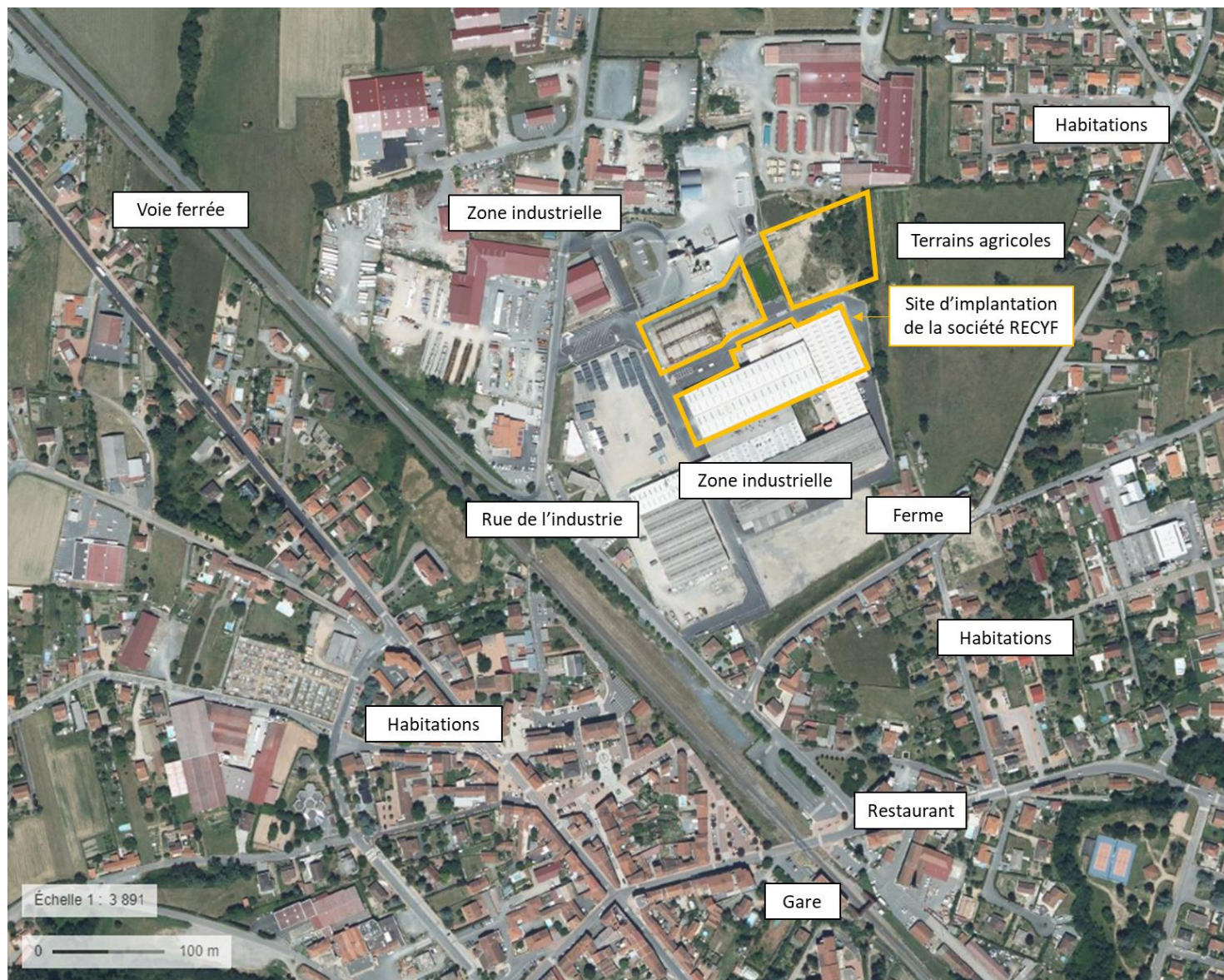
Figure 4 : Vue aérienne du site du projet
