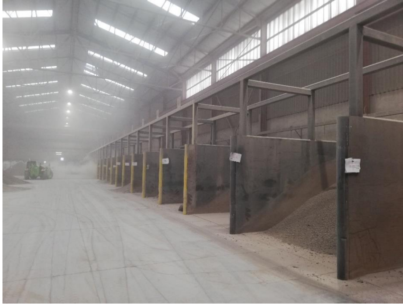
Figure 10 : Box de stockage des matières
